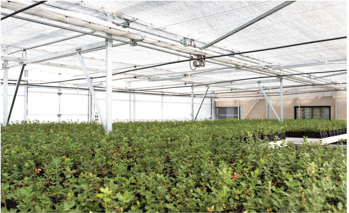
Instalaciones de Inotruf en el polígono de Sarrión
