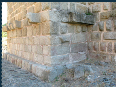
Detalles de la sillaría almohadillada del puente romano de Alcántara (Cáceres).
