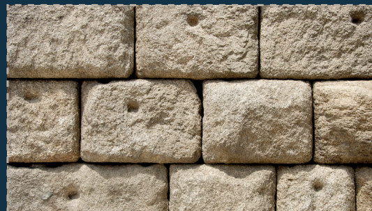
Sillaría con agujeros de las pinzas de hierro en el acueducto de Segovia.
