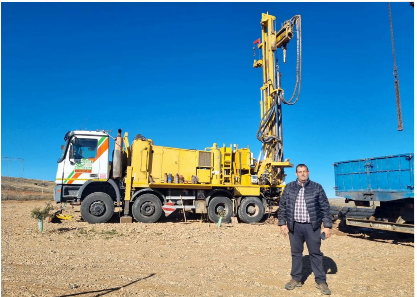
Jorge Álvarez, propietario de Pozos Sondega, junto a una de las perforaciones realizadas recientemente
