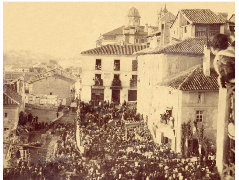
Llegada del obispo a Teruel. Estado de la calle San Francisco con el hundimiento en la calle San Francisco. A la izquierda el ex-convento de Carmelitas y en el centro el Café Central desde donde salía la diligencia hacia Valencia, actual hotel
