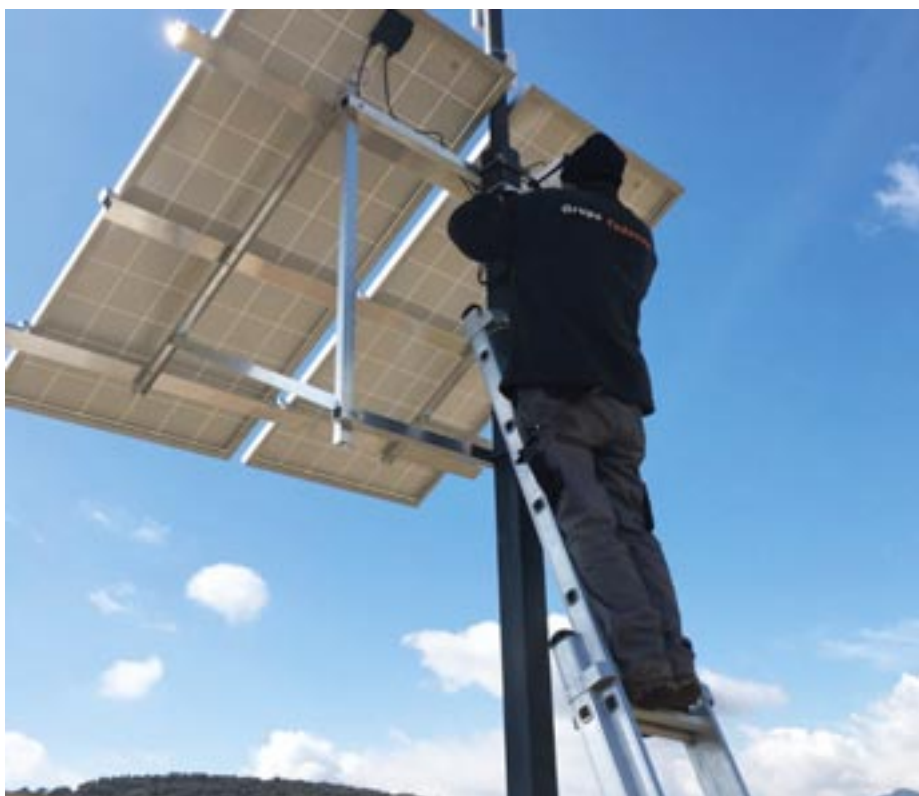
Uno de los operarios, durante la instalación de placas solares
