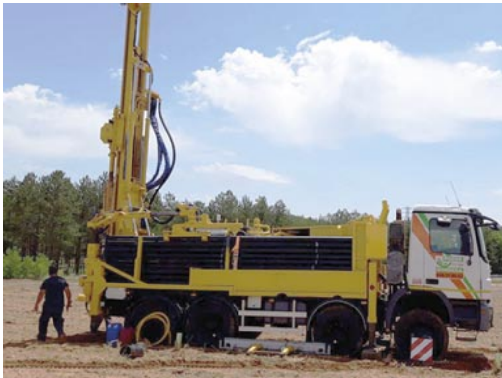
La máquina perforadora torre es una de las más voluminosas
