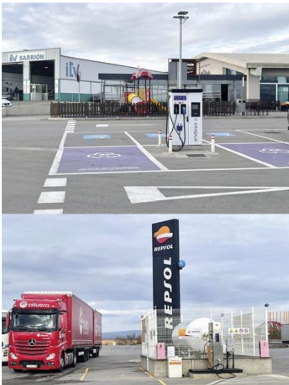
Instalaciones del Asador La Vía Verde y la Estación de Servicio La Pilarica en Sarrión
