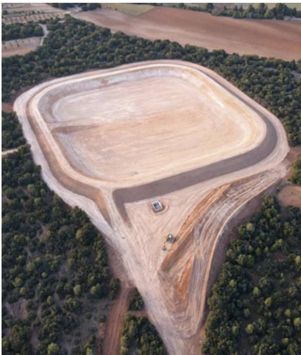
Una de las dos balsas construidas para el almacenaje y posterior distribución del agua de riego
