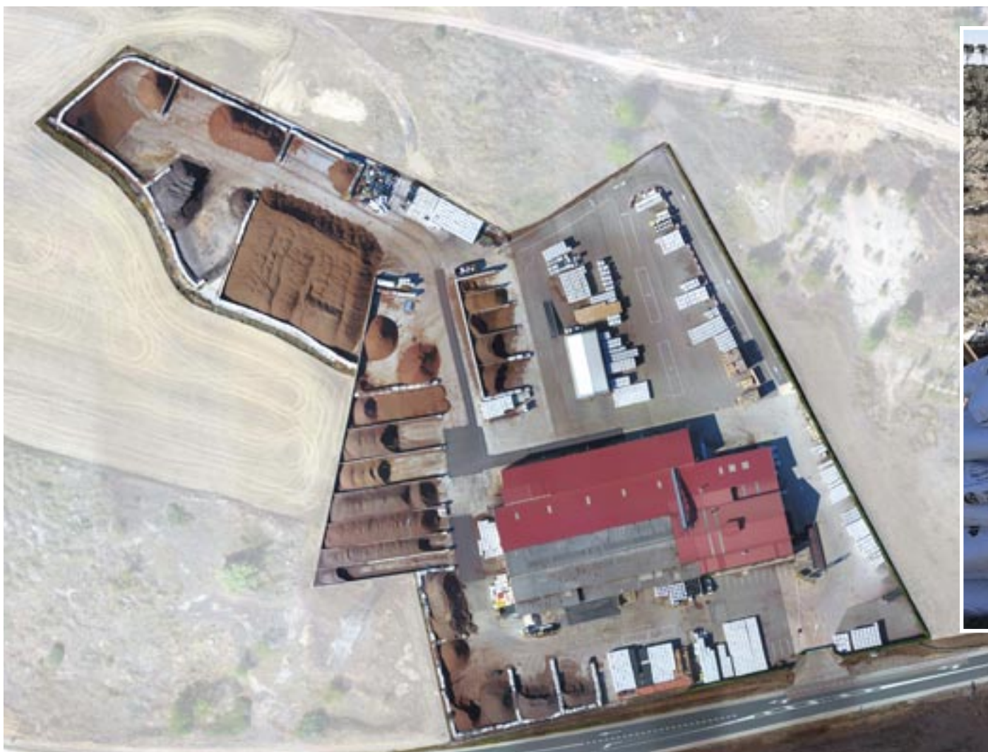
Vista aérea de la fábrica de Pindstrup en Burgos
