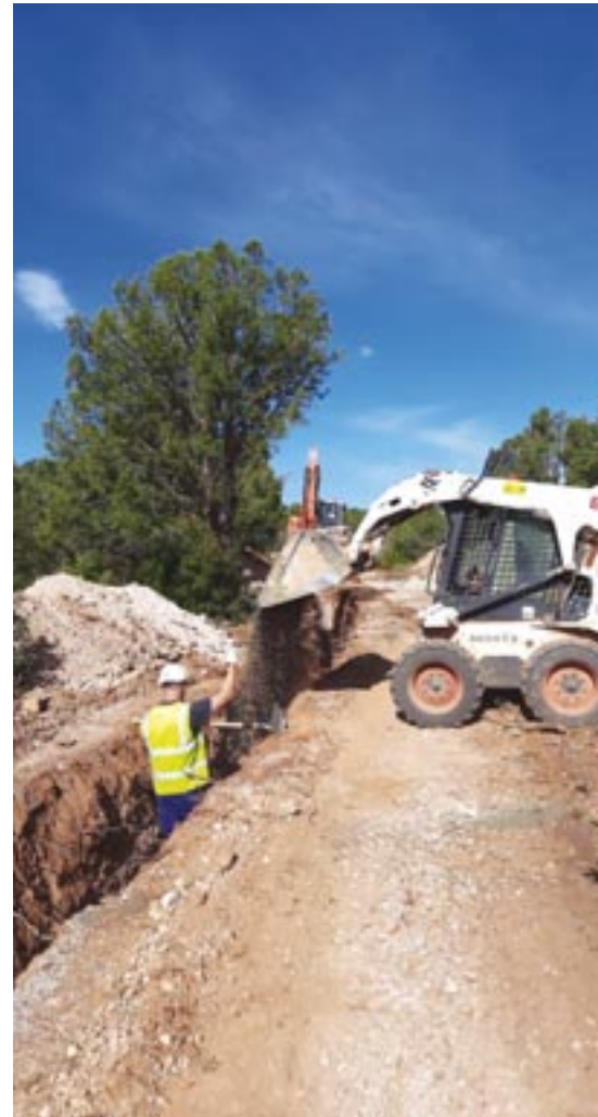
Una máquina, cubriendo una zanja
