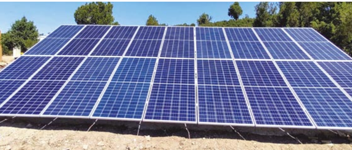
Placas solares para extraer el agua de los pozos
