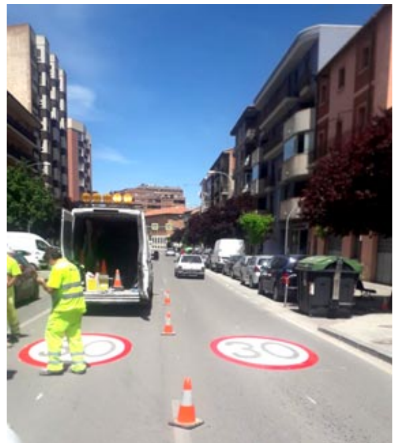
Trabajos de pintura en la avenida Sagunto
