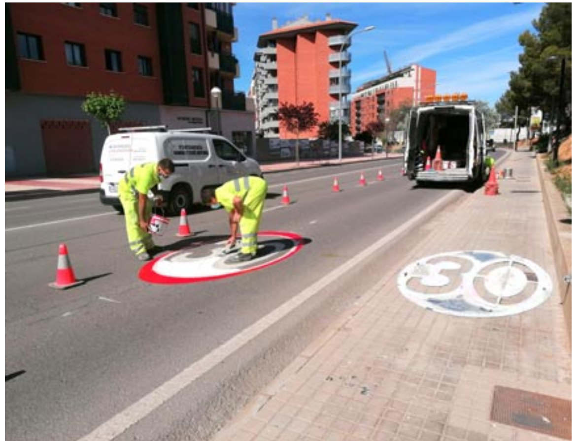
Los carriles a 30 comienzan tras la rotonda de los lápices donde ayer los operarios pintaban las primeras señales
