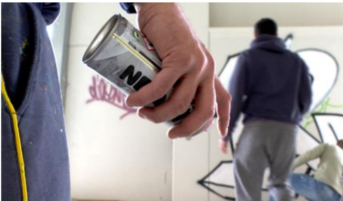
Reparar y sanear las paredes con grafitis ilegales supone un gasto muy elevado. CARTV
