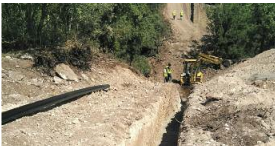
Maquinaria trabajando en la realización de una zanja. Gobierno de Aragón
