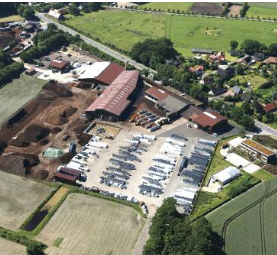
Instalaciones de Gramoflor
