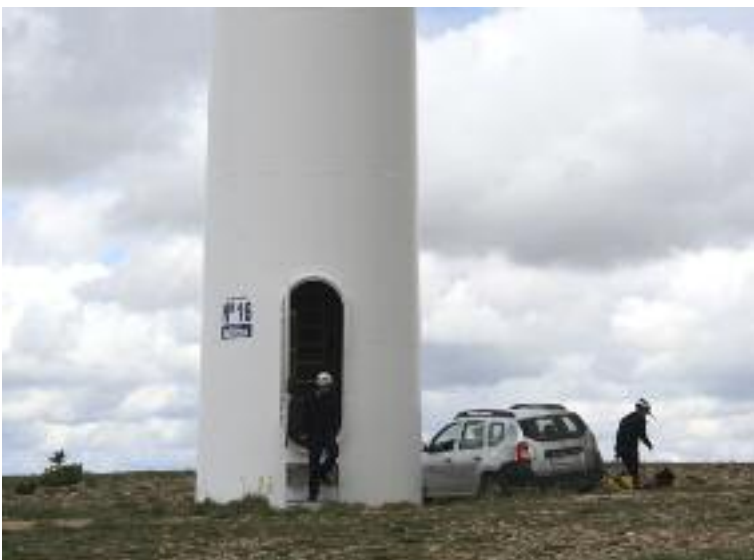
Labores de mantenimiento en uno de los aerogeneradores de San Just. Alicia Royo
