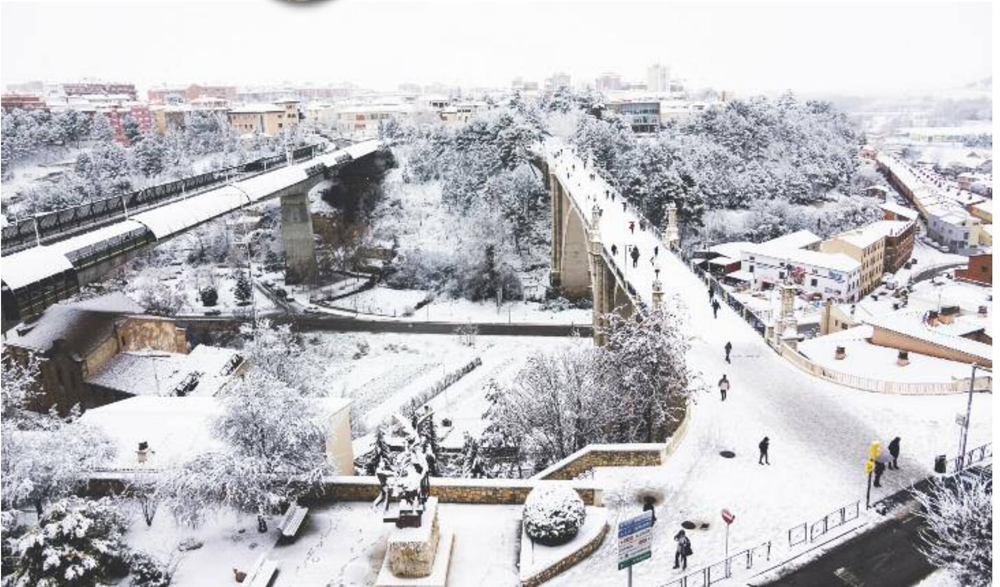
Espectacular imagen de los dos viaductos de Teruel cubiertos de nieve en una mañana de enero de 2017. Antonio García/Bykofoto
